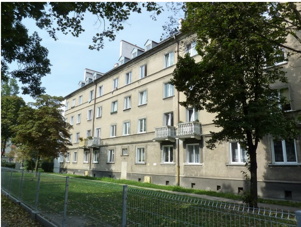
Fot. 2 Elewacja południowa
