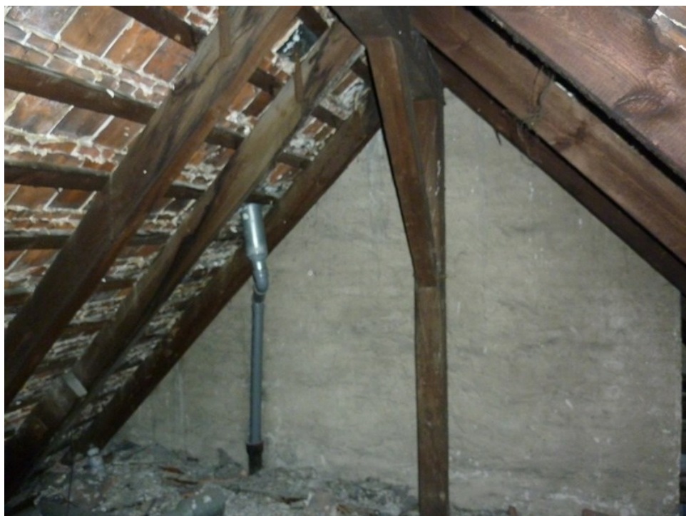
Fot. 4 Fragment więźby dachowej
